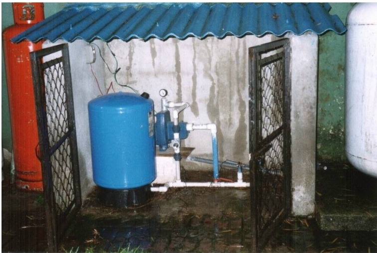
FOTO No. 16 Bomba hidroneumática ubicada en el exterior de un patio, a la par del cilindro de gas
