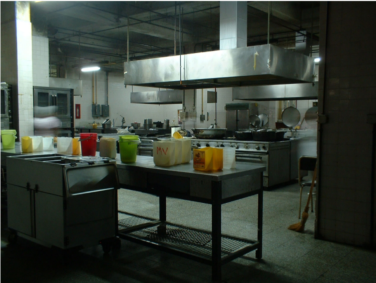
FOTO No. 37 Detalle del área de dietas especiales
