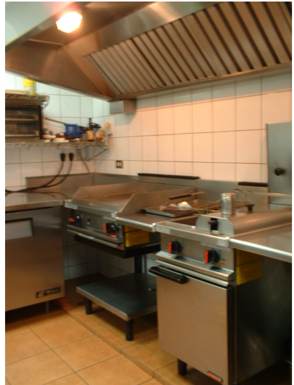
FOTO No. 23 Área de producción, vista de plancha, freidora y campana de extracción
