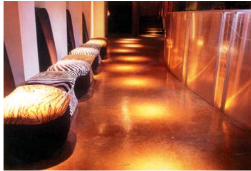
Ilustración No. 16 “Acabado en piso de concreto”
