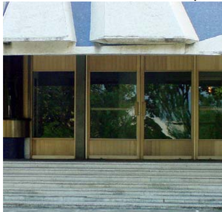
Ilustración No. 21 “Puerta de vidrio y aluminio”
