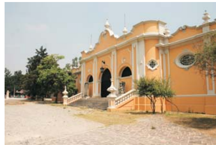
b.2 Puerta sur: Nivel de piso a 1.60 m
