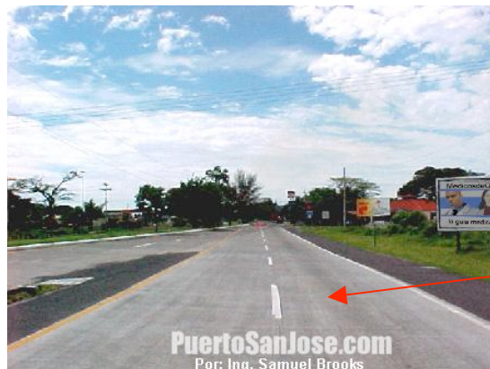
Fotografía No. 24 Carretera CA-9
