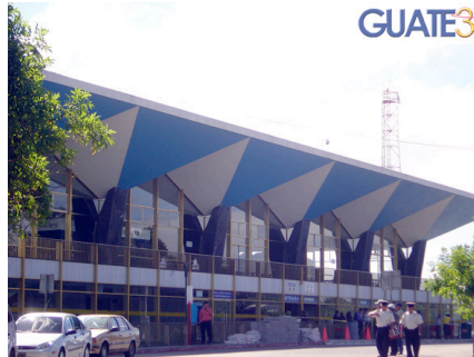
Fotografía No. 6 Aeropuerto La Aurora
