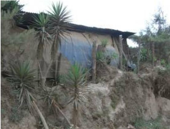
En la fotografía se puede observar el uso de nylon en los muros, la altura de la vivienda y las cubiertas de lámina, que por lo general se encuentran dañadas por el óxido.
