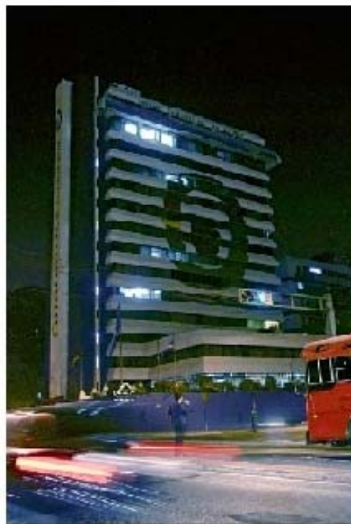
Fig. 12 Instalaciones del INGUAT
