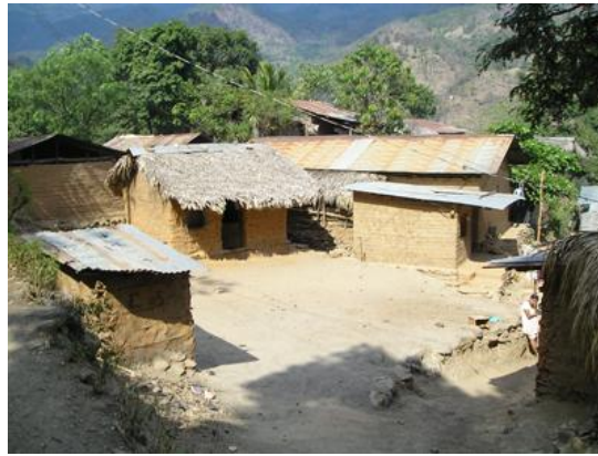
Fotografía No.1 Casa de Chanrayo
