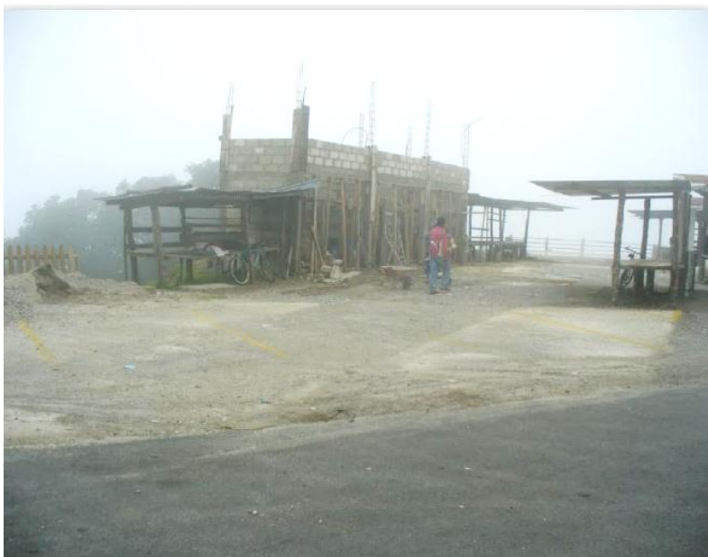
Fotografía No. 16 Nueva infraestructura.
