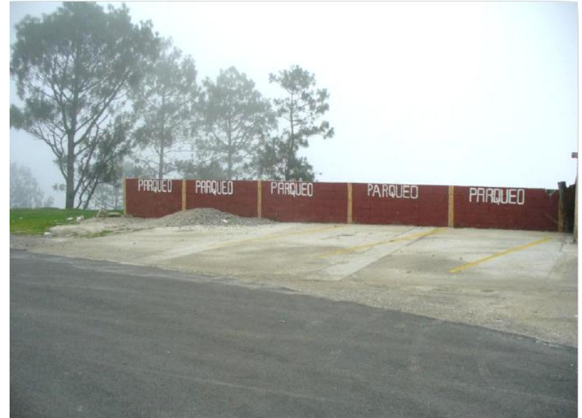
Fotografía No. 15 Estado del parqueo
