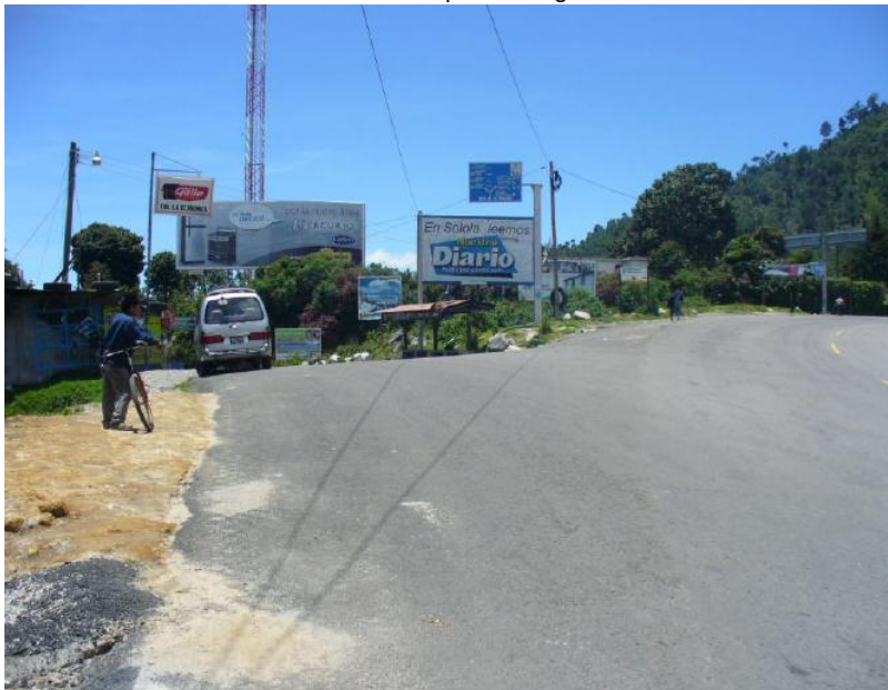
Fotografía No 24 Vista del entronque de ingreso
