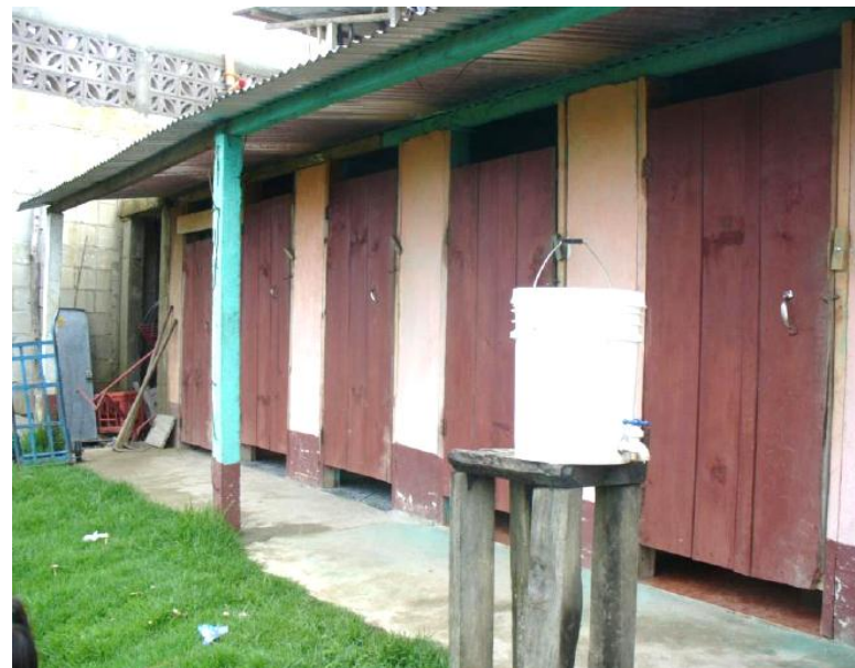
Fotografía No. 19 Servicios sanitarios.
