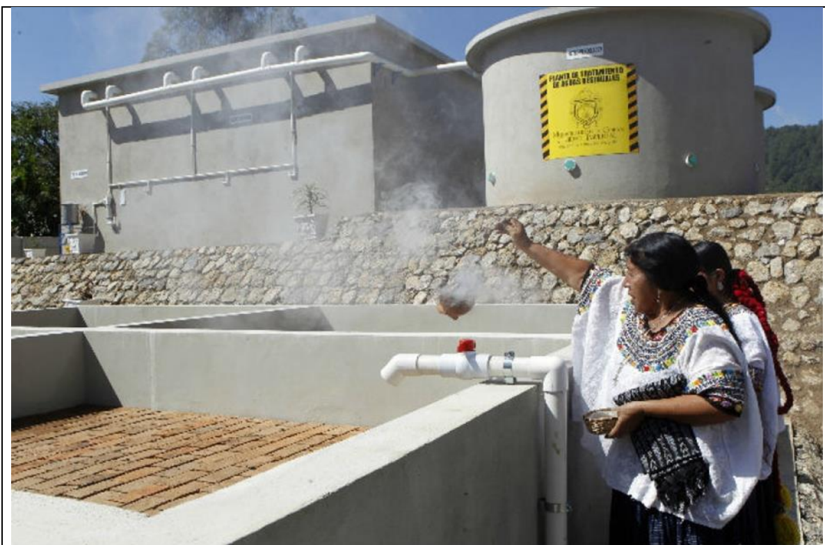
Inauguración de la Planta de Tratamiento de Aguas Residuales Municipales, Cobán, Alta Verapaz, Guatemala Fuente: http://www.guatemala.gob.gt/index.php/2011-08-04-18-06-26/item/2305-inauguran-planta-de-tratamiento . Consultado el 2 de septiembre de 2013.
