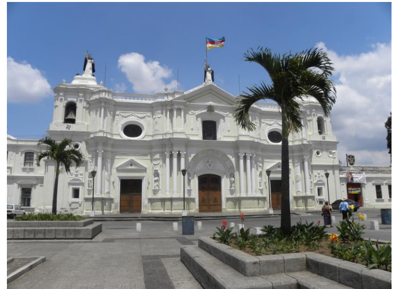
Fotografía No.20 Iglesia Sto. Domingo
