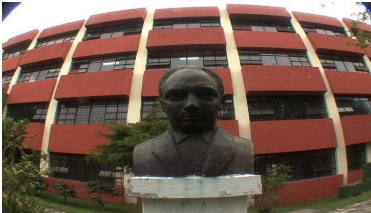
Figura No. 7 Fachada Frontal ENAP
