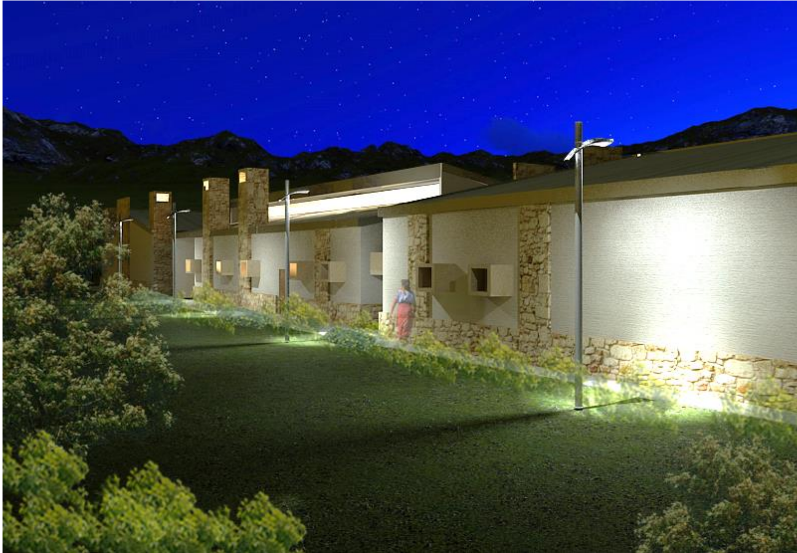
Vista exterior del Centro Asistencial
