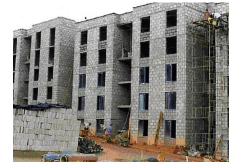
Fotografía No. 9 Edificio de mampostería
