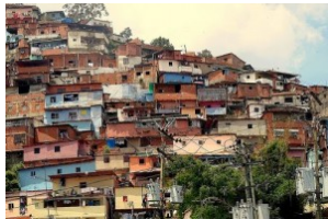
Fotografía No. 7 Viviendas en asentamiento
