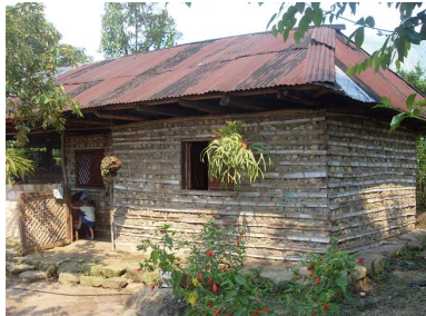
Fotografía No. 3 Vivienda Rural
