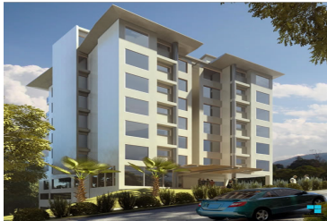
Fotografía No. 5 Edificio de apartamentos La Torre
