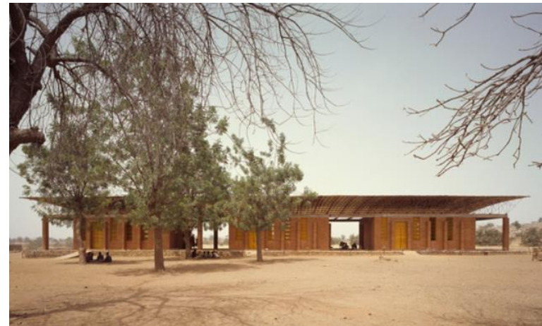
Figura 5 Escuela primaria en Gando área exterior
