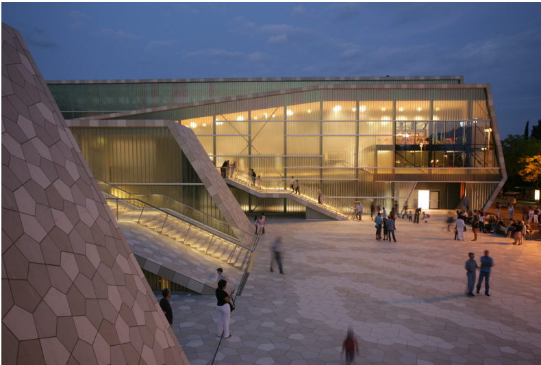
Figura No.21. Exterior Zamet Center
