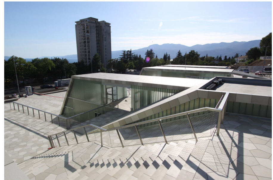
Figura No.20. Exterior Zamet Center
