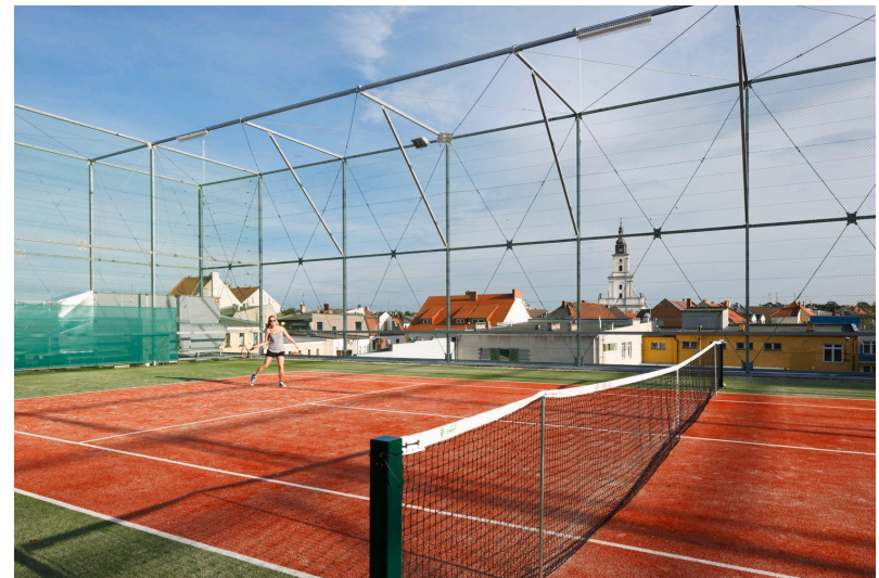
Figura No.18. Azotea Cancha de Tenis en Fala Park
