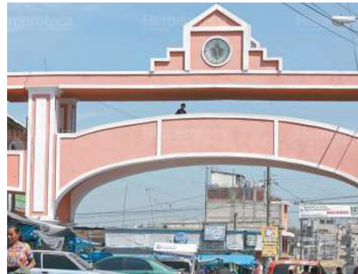
Figura No. 27: pasarela que conecta con la cuadra del mercado
