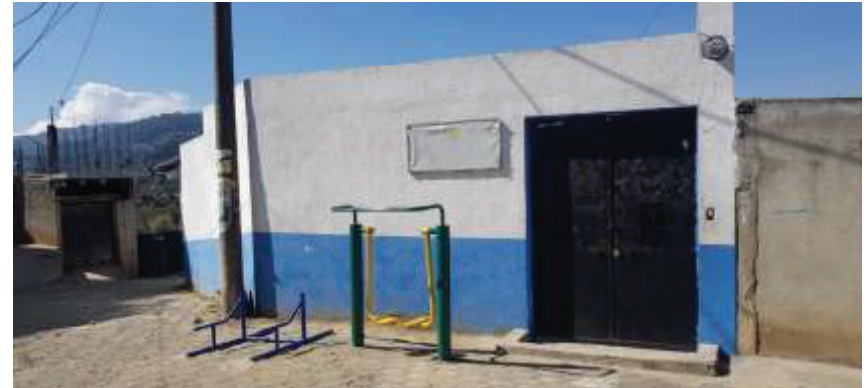
Fotografía No. 1: Estado actual del exterior de la guardería municipal
