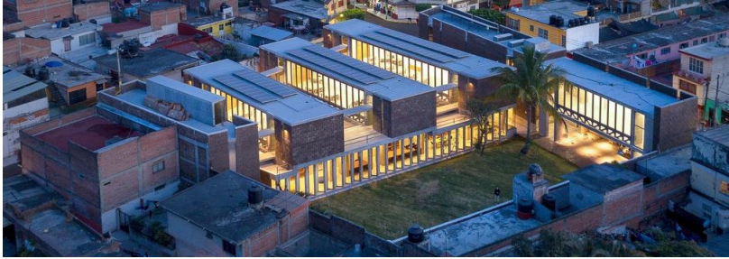
Figura No. 2: Vista Área proyecto “Centro de desarrollo comunitario los chocolates”
