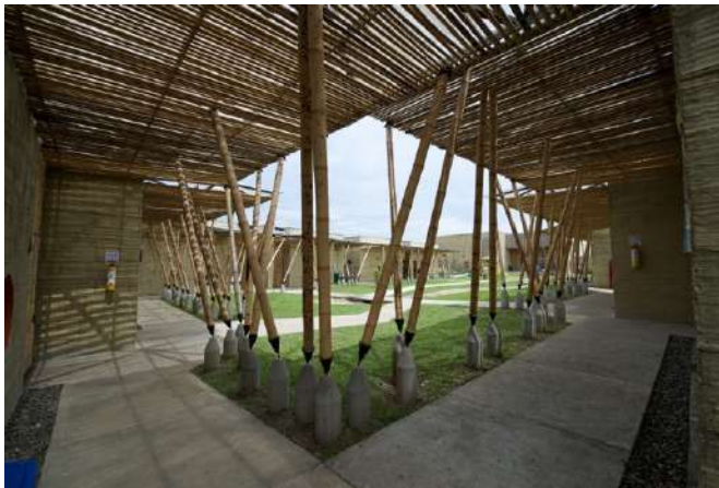
Figura 17. Pasillo CDI Fuente: Plataforma Arquitectura (2015)
