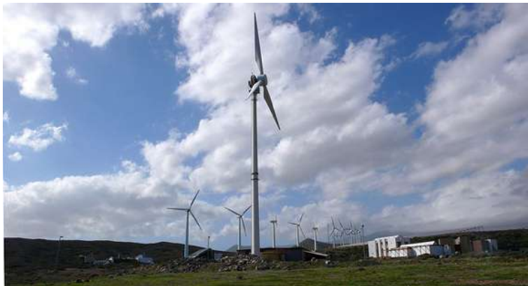
Figura. 6 Ejemplo en uso de aerogeneradores
