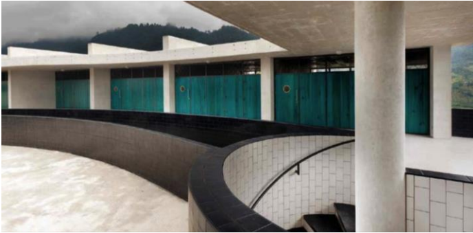
Escuela San Juan Cotzal Vista Interior
