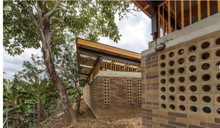
Escuela Primaria en Colombia Vista de Costado
