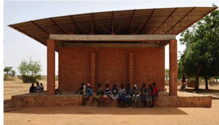
Escuela Primaria en Gando Vista Frontal
